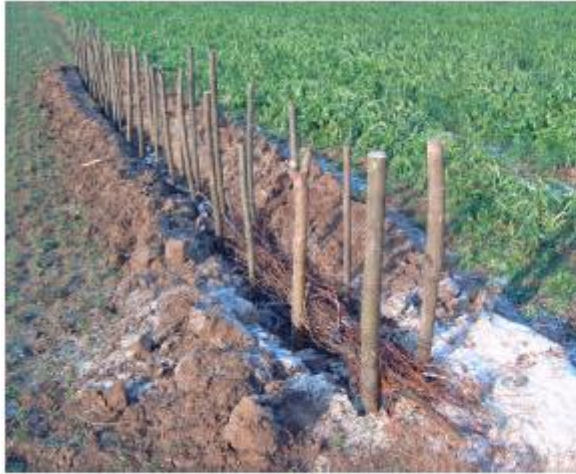
Préparation de la tranchée
